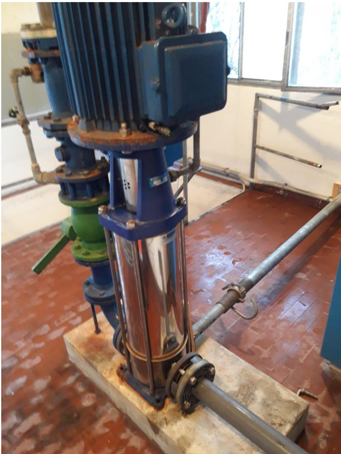
L'attuale pompa ha una portata di 400 lt7min del tipo DPL 32-130/12 con una potenza di 18.5 KW
