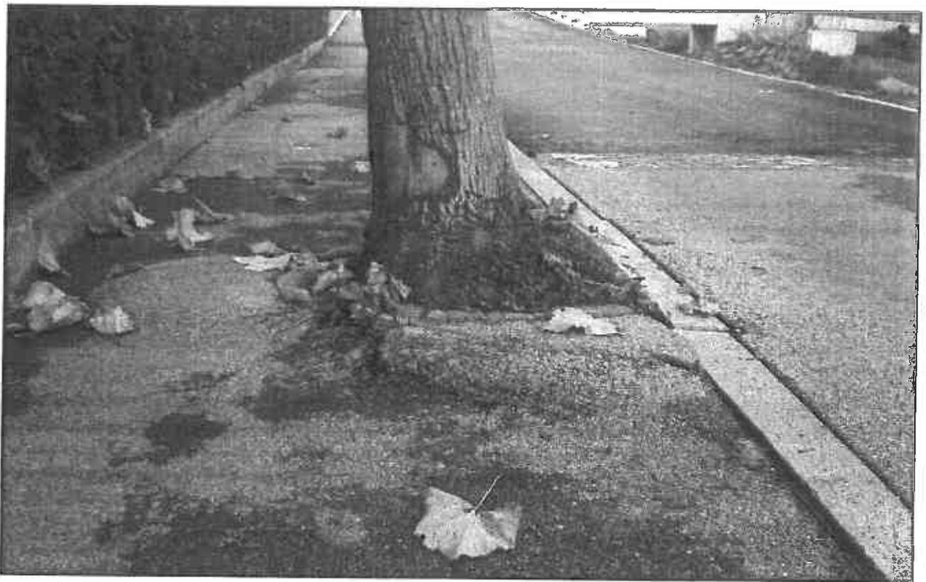
*Esempio sconnessioni nella pavimentazione dovute alle radici dell'alberatura*
