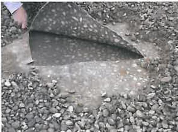
Foto 2: impermeabilizzazione + strati isolanti esistenti
